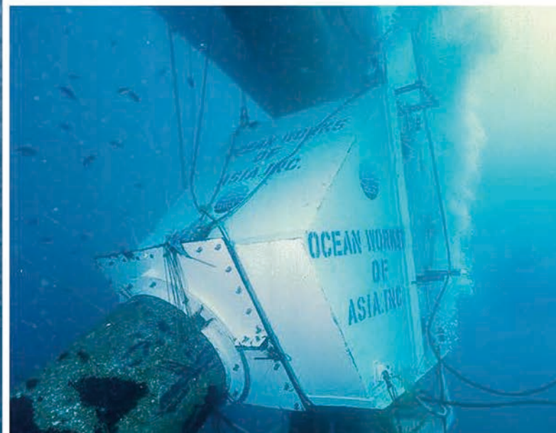
水中ドライ溶接チャンバー Underwater hyperbaric welding chamber
